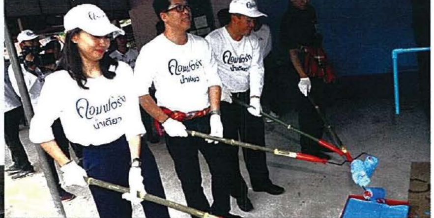
กิจกรรมปรับปรุงอาคารกรองน้ำดื่ม
