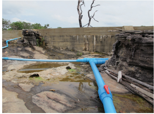
ภาพแสดงฝายวังอีแร้ง ๑ ปริมาณความจุน้ำ ๓๐,๐๐๐ ลูกบาศก์เมตร และท่อพีวีซีขนาด ๖ นิ้ว เพื่อส่งน้ำเข้าพื้นที่เกษตร ๓๐๐ ไร่
