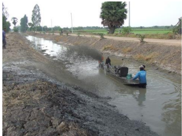
ขุดลอกเปิดทางน้ำในคลองส่งน้ำ
